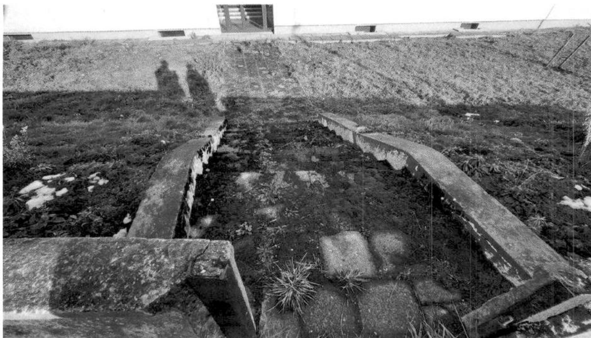
Schody i chodnik po stronie południowej budynku szkoły
