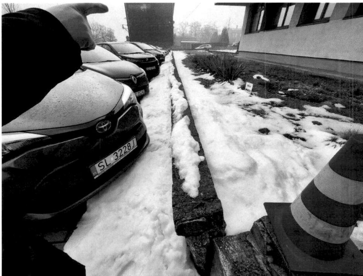
Murek oporowy na parkingu
